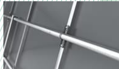
Photos 2 - 3 : Adaptateur et languette de fixation pour le montage du système de garde-corps périphérique, type : ABS Guard onTop Shed sur l'ouvrage
