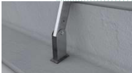
Photos 2 - 3 : Adaptateur et languette de fixation pour le montage du système de garde-corps périphérique, type : ABS Guard onTop Shed sur l'ouvrage
