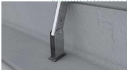
Bilder 2 - 3: Adapter und Befestigungslasche zur Montage des Seitenschutzsystem, Typ: ABS Guard onTop Shed am Bauwerk
