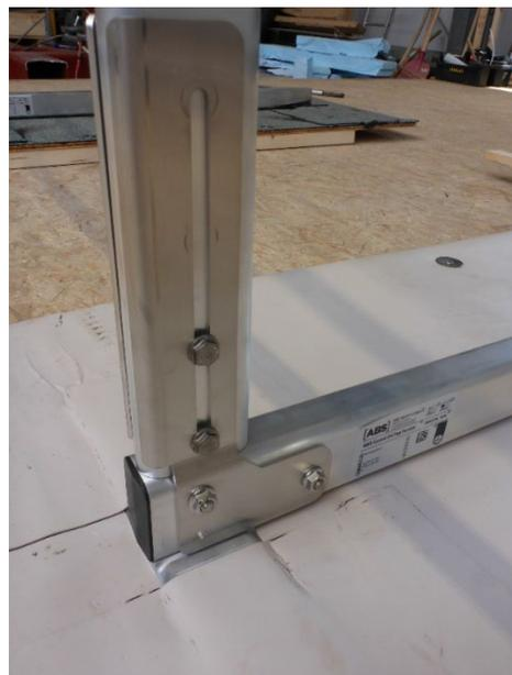
Detail zu höhenverstellbarem Pfosten – links maximale Höhe - rechts minimale Höhe
